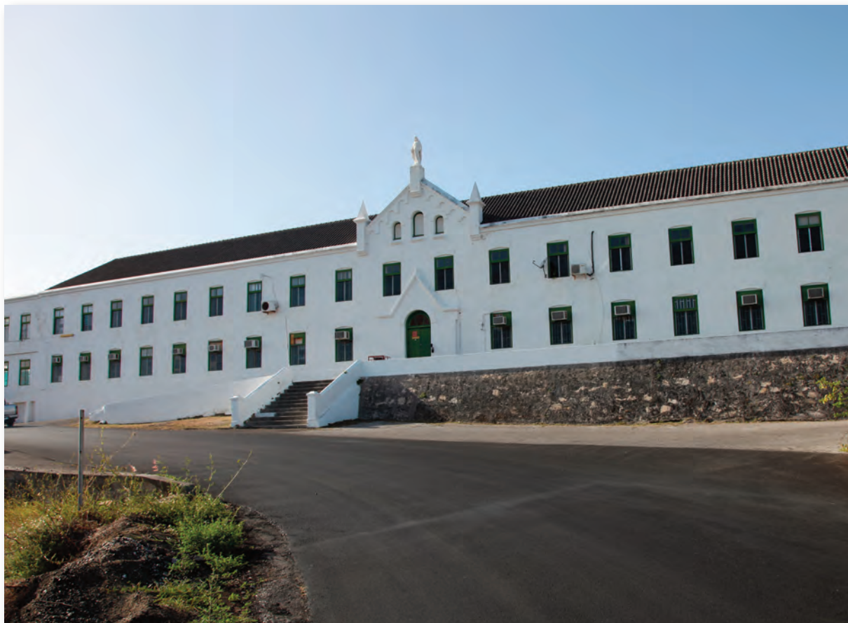
Het imposante gebouw van Scherpenheuvel
